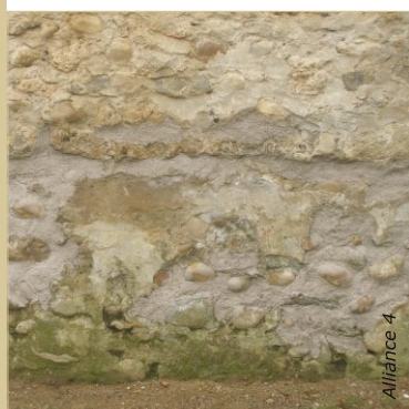
Reprise du mur avec des galets et un mortier de chaux NHL2/sable. La consolidation du support est une phase importante de la préparation.
