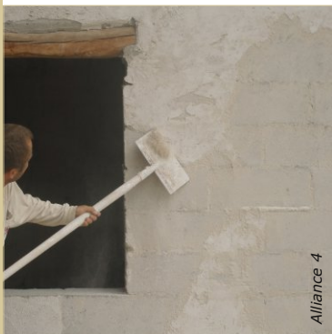
Gratter les enduits anciens dont la tenue est mauvaise. Sur le bâti ancien, retirer si possible les revêtements à base de ciment ou de résine.
