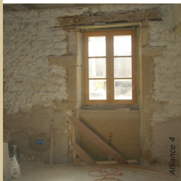
Préparation de cet ancien mur en pierre : gobetis avant application d'un enduit chaux/chanvre + rupture thermique en béton de chanvre sous la fenêtre + enduit chaux/ponce sur le soubassement agissant comme tampon hygrométrique.
