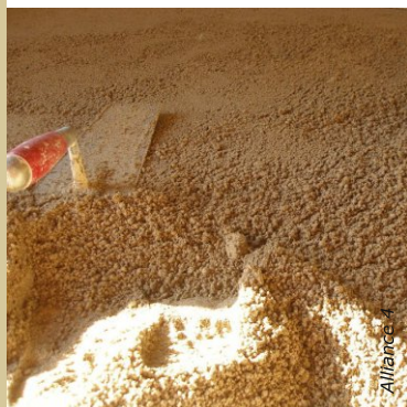
La consistance du mortier de chaux est plutôt sèche.
