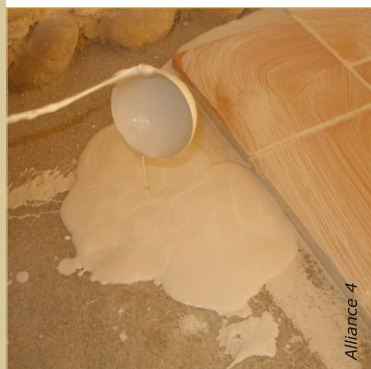
Etaler généreusement la barbotine sur la surface de quelques carreaux.
