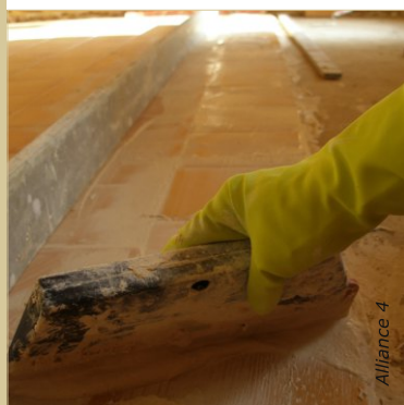
Garnir plusieurs fois les joints et étaler à la raclette en caoutchouc. Racler l'excédent et nettoyer dès que possible.
