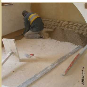
Commencer par tirer des nus le long des murs : ces bordures maçonnées servent de niveau pour tirer la partie centrale.
