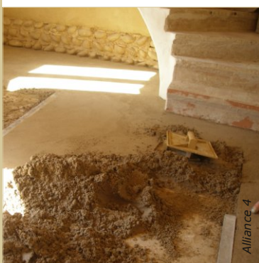
Un nu central facilite le contrôle des niveaux et la mise en place de la chape.
