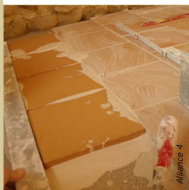
Poser en ligne en vérifiant régulièrement l'alignement du rang et l'épaisseur des joints.
