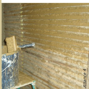
La barbotine d'argile est appliquée à la brosse et assurera une bonne accroche au corps d'enduit.
