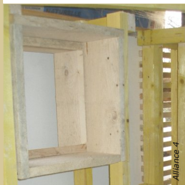
Les cadres des menuiseries sont posés en cours de remplissage afin de faciliter les accès lors du tassage.
