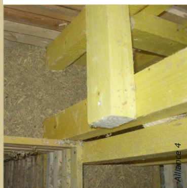
Les faces intérieures et extérieures de l'ossature, accueillant le lattes, sont reliées entre elles de manière ponctuelle.
