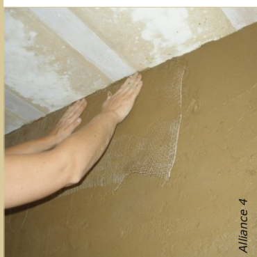
Si des bois sont amenés à être recouverts d'enduit, intégrer une toile de jute dans le corps d'enduit pour limiter les fissurations.
