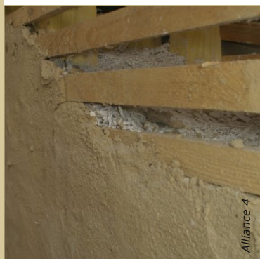
L'enduit à l'argile fibré recouvre les lattes et s'incruste dans l'entre-lattes. On obtient un ouvrage monolithique, sans déperdition thermique.
