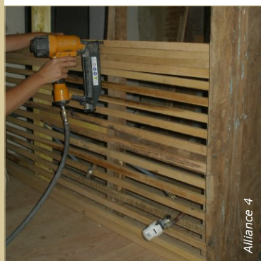
Fixer rapidement et régulièrement le lattes : présenter plusieurs lattes contre les montants, n'en couler qu'une sur deux. Retirer les lattes non fixées.
