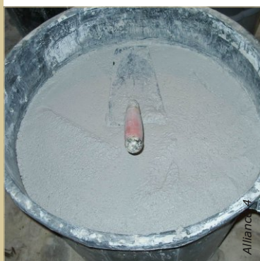
Le gobetis à la chaux aérienne doit être préparé au moins la veille de sa mise en œuvre. Il se conserve sous une couche d'eau pendant plusieurs semaines.
