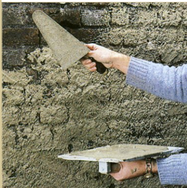
Le jeté du gobetis est un mouvement sec du poignet, et non du bras.
