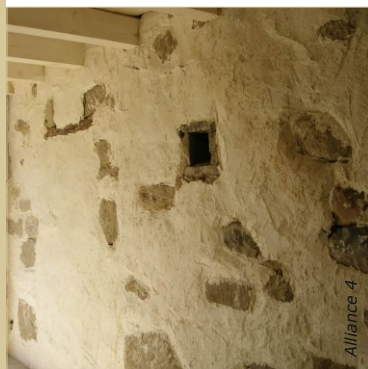
L'enduit chanvre est parfaitement adapté au bâti ancien. Il agit en continuité des murs existants.
