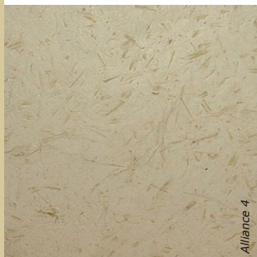
Le rendu soyeux, avec les paillettes de chanvre en surface, est obtenu par le travail de ferrage de l'enduit
