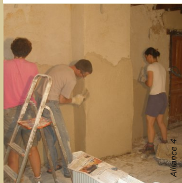
Pour les grandes surfaces, travailler à plusieurs afin d'éviter les traces de reprises.
