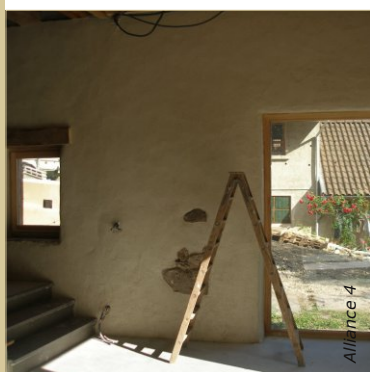
Après : Enduit chaux/chanvre terminé.
