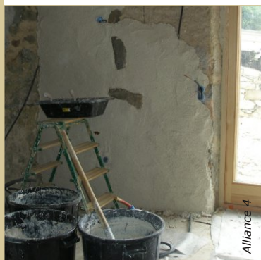
Application de l'enduit chaux/chanvre sur un mur ancien en pierre. Les gaines et boîtiers électriques sont noyés dans l'épaisseur de l'enduit. Certaines pierres saillantes sont laissées apparentes.
