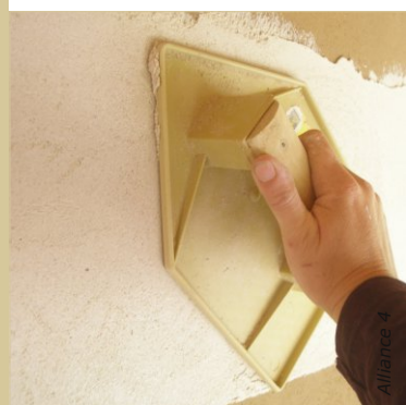
Une belle planéité s'obtient par le talochage, avec une taloche classique ou une taloche-éponge. Il permet d'égaliser les creux et les bosses.
