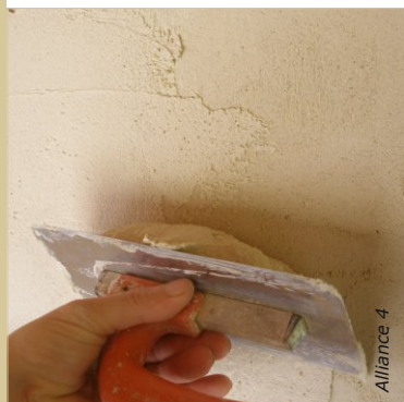
La seconde passe s'applique sur la première déjà ferme sous la pression du doigt.
