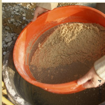
Tamiser tous les ingrédients pour assurer une finition de qualité. Les impuretés et éléments hors granulométrie gênent lors de l'application.
