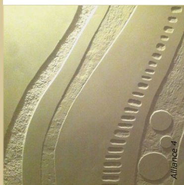
La technique du sgraffito consiste à graver un enduit à frais. Les variations de profondeur des incisions permettent de retirer une ou plusieurs passes, faisant apparaître les enduits précédents.
