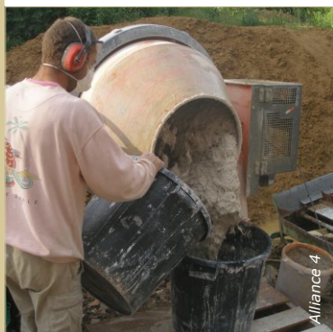
Préparation de l'enduit en bétonnière. La consistance de sortie est bien fluide.
