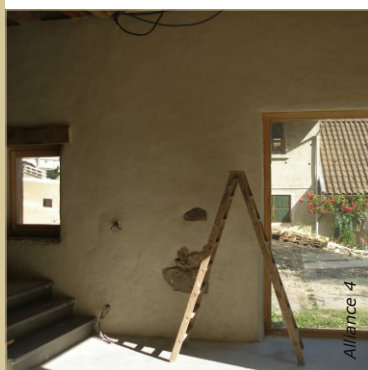
Après : les ponts thermiques ont disparus, les équipements électriques ont été noyés dans l'enduit. Certains éléments anciens ont été conservés : ferrure, pièces de bois, pierres en saillie. Les angles sont arrondis.
