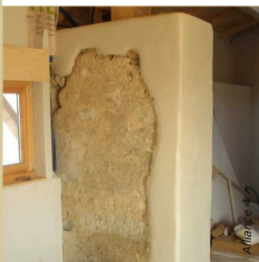
L'enduit chanvre s'utilise aussi en usage purement décoratif : ici des reprises de maçonnerie ont été recouvertes d'un enduit chaux/chanvre. Le mur ancien a été ainsi mis en valeur.
