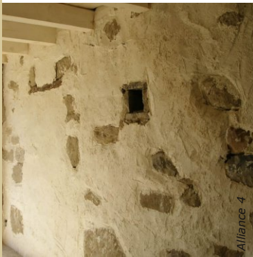
L'enduit chaux/chanvre est parfaitement adapté au bâti ancien. Ici la première couche appliquée grossièrement est en cours de séchage. Elle recevra deux passes de finition posées à frais l'une après l'autre.
