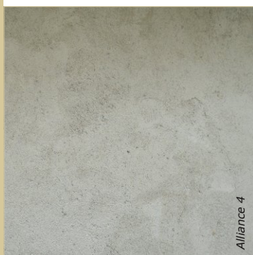
Le corps d'enduit peut rester tel quel, définitivement ou en attente d'une finition ultérieure.
