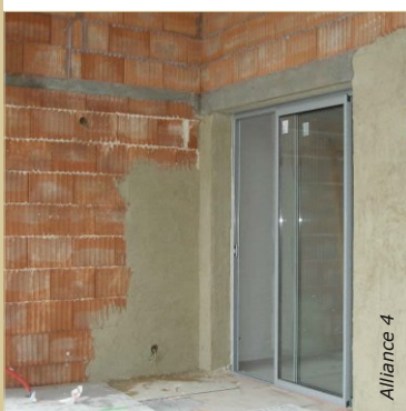
Humidifier généreusement les briques en terre cuite, la veille et avant l'application du gobetis. Mettre en œuvre le corps d'enduit sur le gobetis ferme.
