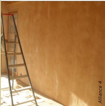
Corps d'enduit teinté ocre rouge, simplement taloché pour un aspect en matière.
