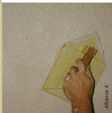
Le talochage est un mouvement circulaire bien appuyé. Il permet d'obtenir la planéité en égalisant les creux et les bosses. Rajouter localement de la matière si besoin.
