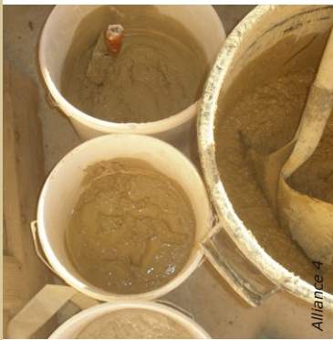
La teinte de l'argile, et celle des sables utilisés, influence la coloration de l'enduit. La recherche de teinte consiste à faire des essais et des échantillons sur site.
