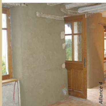
Le corps d'enduit peut rester tel quel, définitivement ou en attente d'une finition ultérieure. Il convient de le laisser sécher totalement avant d'appliquer la finition.
