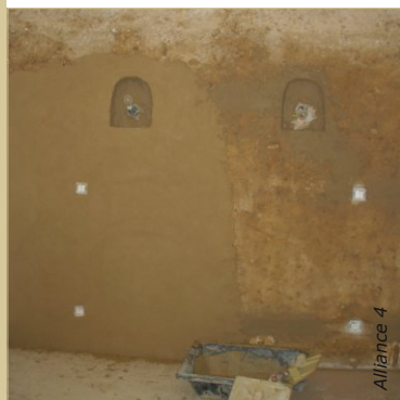
Bien humidifier le support en cours de pose. Soigner l'application autour des prises et des interrupteurs.
