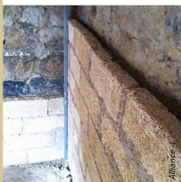
Doublage d'un mur en pierre avec des briques de chanvre. Le vide entre les briques et le mur est comblé avec du chanvre stabilisé.
