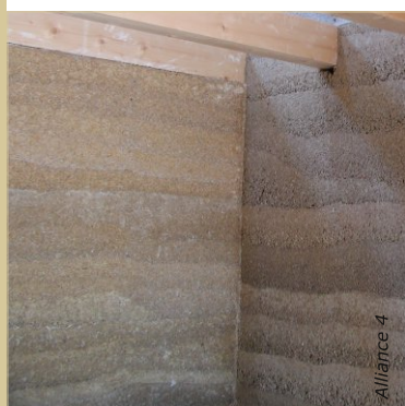
Le béton de chanvre est une alternative économique aux briques de chanvre. Il permet de réaliser des ouvrages monolithiques, mis en œuvre sur place dans un coffrage.
