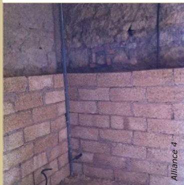
Les briques se montent en croisant les joints d'un rang sur l'autre.
