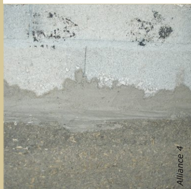
Une mortier chaux/plâtre permet de réaliser des équerres maçonnées pour solidifier le doublage au mur existant.
