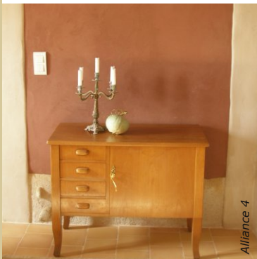
L'enduit de finition a été posé en dernier. Ici, il est encadré par les jambages des ouvertures, le sous-bassement et le plafond.
