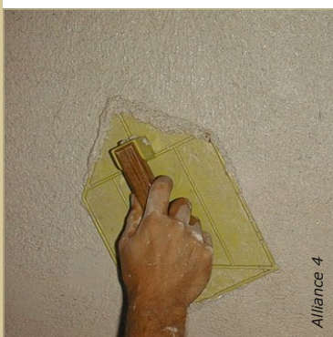
Talocher le corps d'enduit dès qu'il commence à être ferme : les mouvements circulaires bien appuyés déplacent la matière, aplatissent les bosses et comblent les creux.
