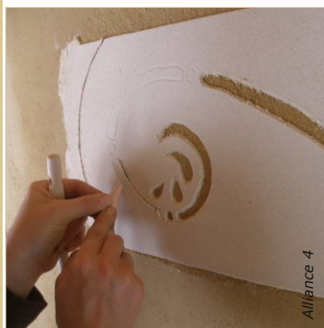
Les enduits de finition peuvent être gravés ou découpés. Cette technique s'appelle sgraffito.
