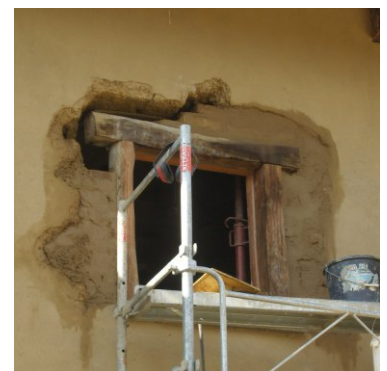
Pour cette ouverture, les adobes ont servi à combler l'espace entre le pisé et le bois, sur les côtés et le dessus du cadre.
